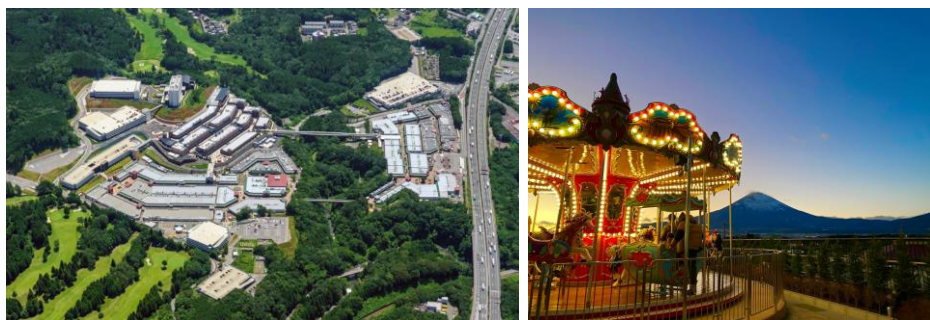
増設し 3 エリアが橋でつながった御殿場プレミアム・アウトレット
